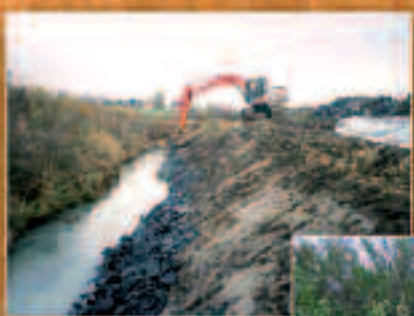
Contrôle de l'écoulement (Sondages - pénétrométrie sculptée à la pelle, etc.)
