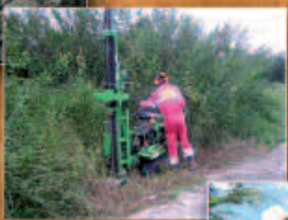
Détermination des systèmes de fondations et des structures construites (à l'aide de proues)
