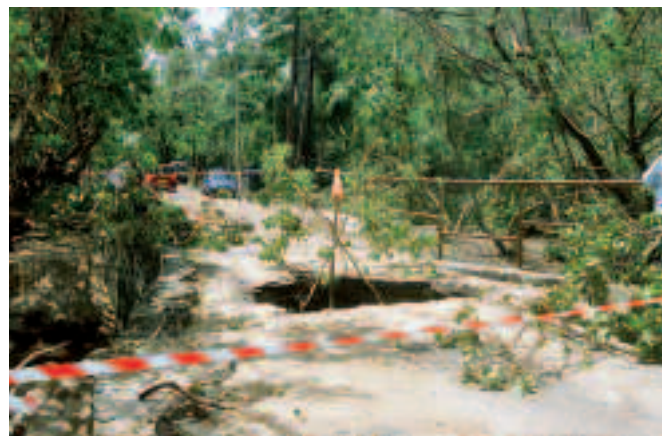
Écroulement de la chaussée - Quartier Cosmy - Août 2007
