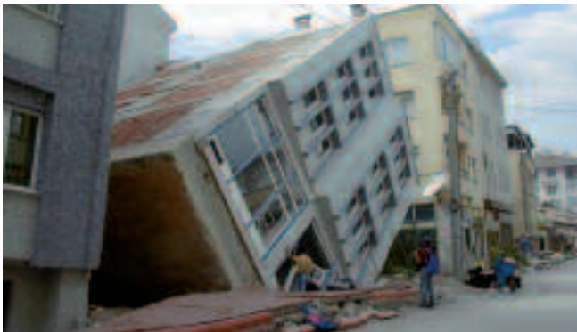
Bâtiment incliné suite à la liquéfaction des sols de fondation. BRGM / P. Mouroux - Séisme (7,8) de Gölcük-17 août 1999 (Adapazari, Turquie)
