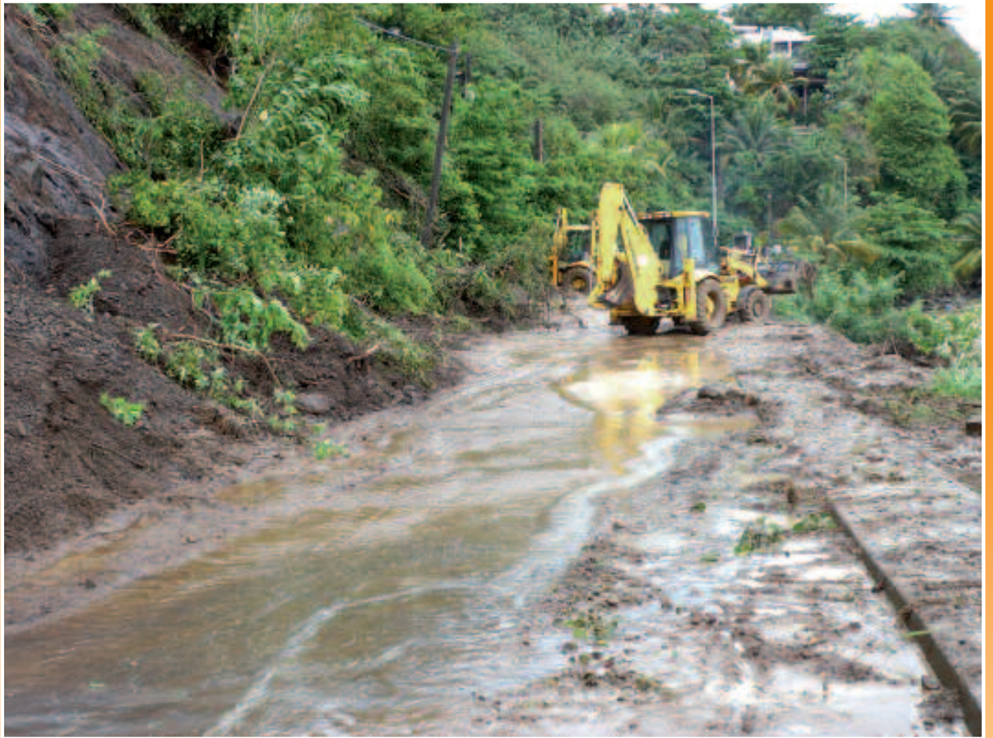
Intervention des services techniques de la Ville suite aux intempéries du 05 / 05 / 09
